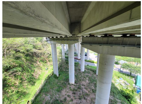
교각 P3 기초 전경
