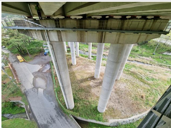
교각 P6 기초 전경
