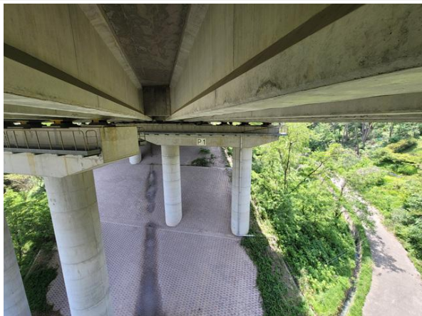
교각 P1 기초 전경
