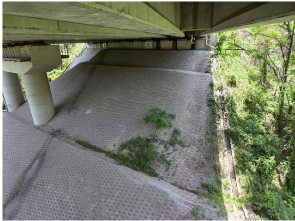
교대 A1 기초 전경
