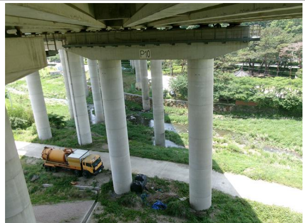
교각 P10 기초 전경
