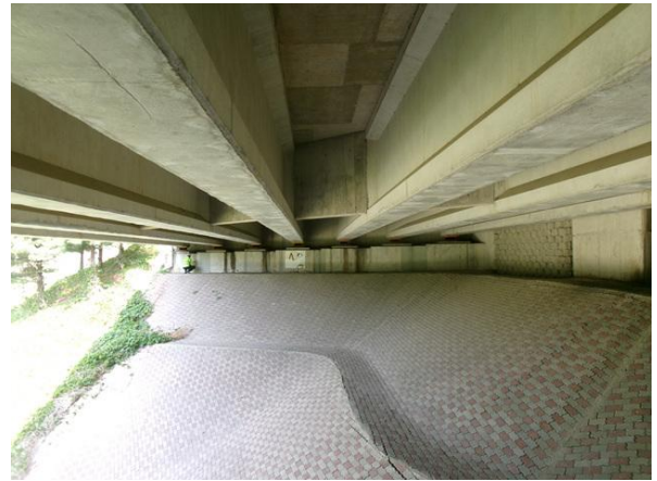
교대 A2 기초 전경
